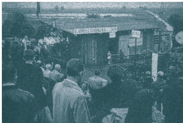
Uroczyste otwarcie przepompowni, 1946 r. Zdjęcie archiwalne rodziny. Official opening of the pumping station, 1946 Archive photograph from the family's collection.
